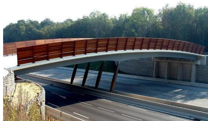
Passage à faune sur la N2 sur la commune d'Urcel
